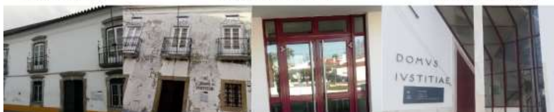
Edifício do TEP/TT
